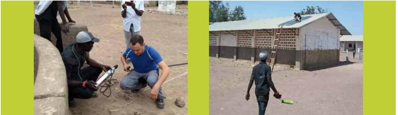
Instalación de la bomba de agua y de las placas solares que le suministran la energía necesaria para su funcionamiento
