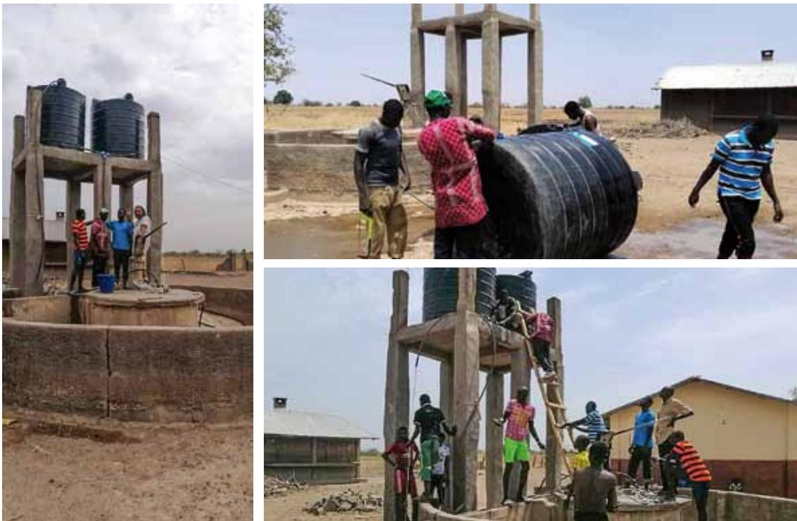
Reconstrucción de la estructura para la colocación de los depósitos del Sistema de Agua de la Escuela de Njoreng
