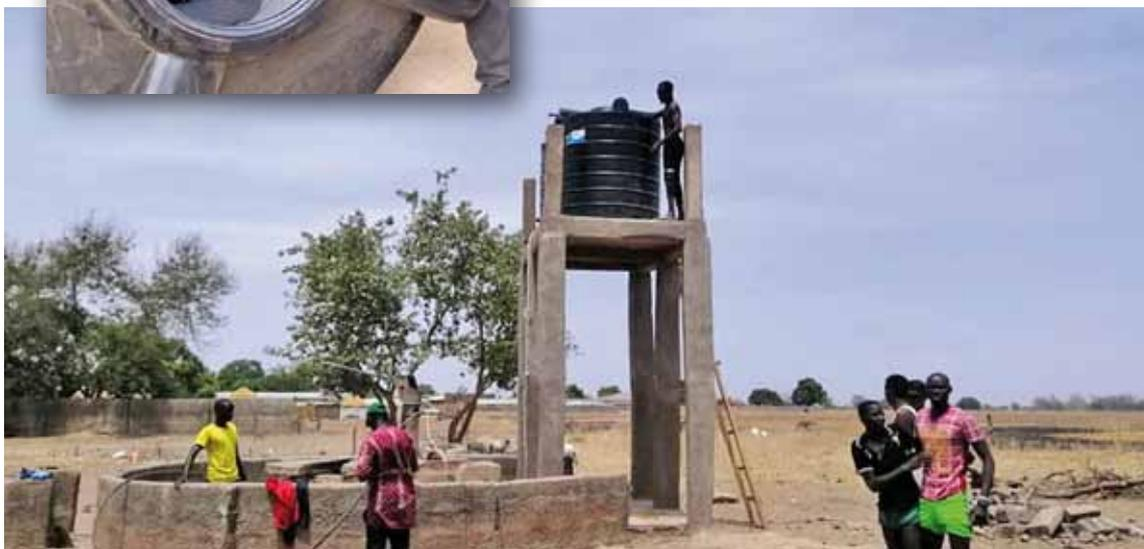
Finalización de la estructura de soporte y colocación de los depósitos de agua para la bomba solar
